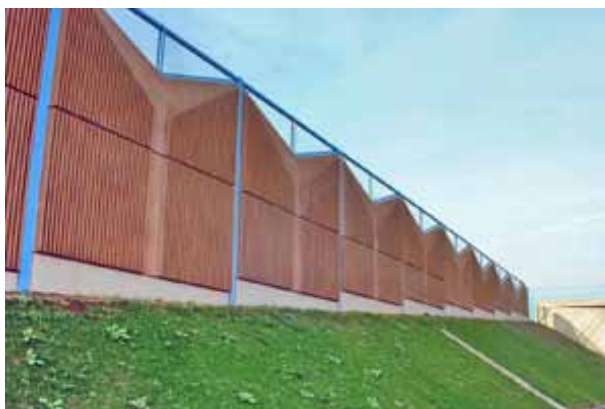
Obr. 2 Protihluková stěna Liadur
