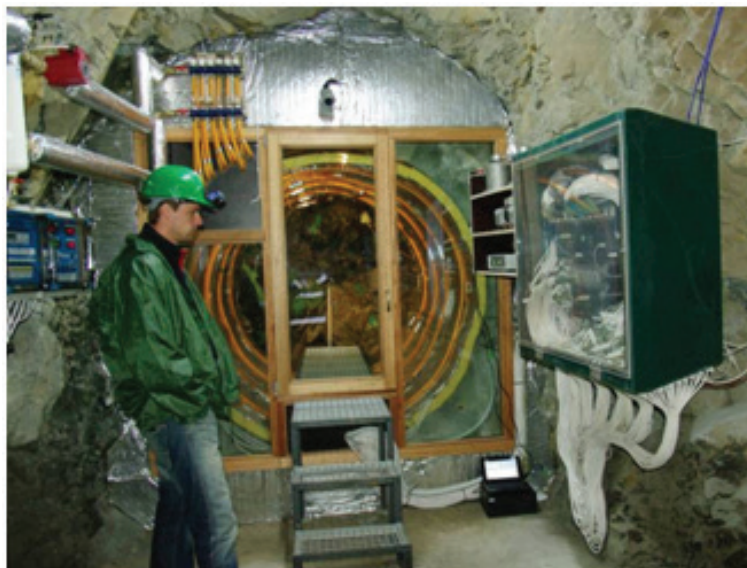
Obr. 1 uložení ve štole
